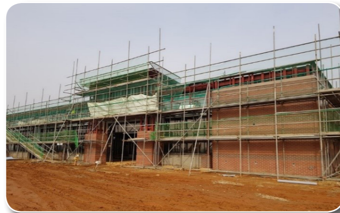
Mini Mall Construction Ongoing
