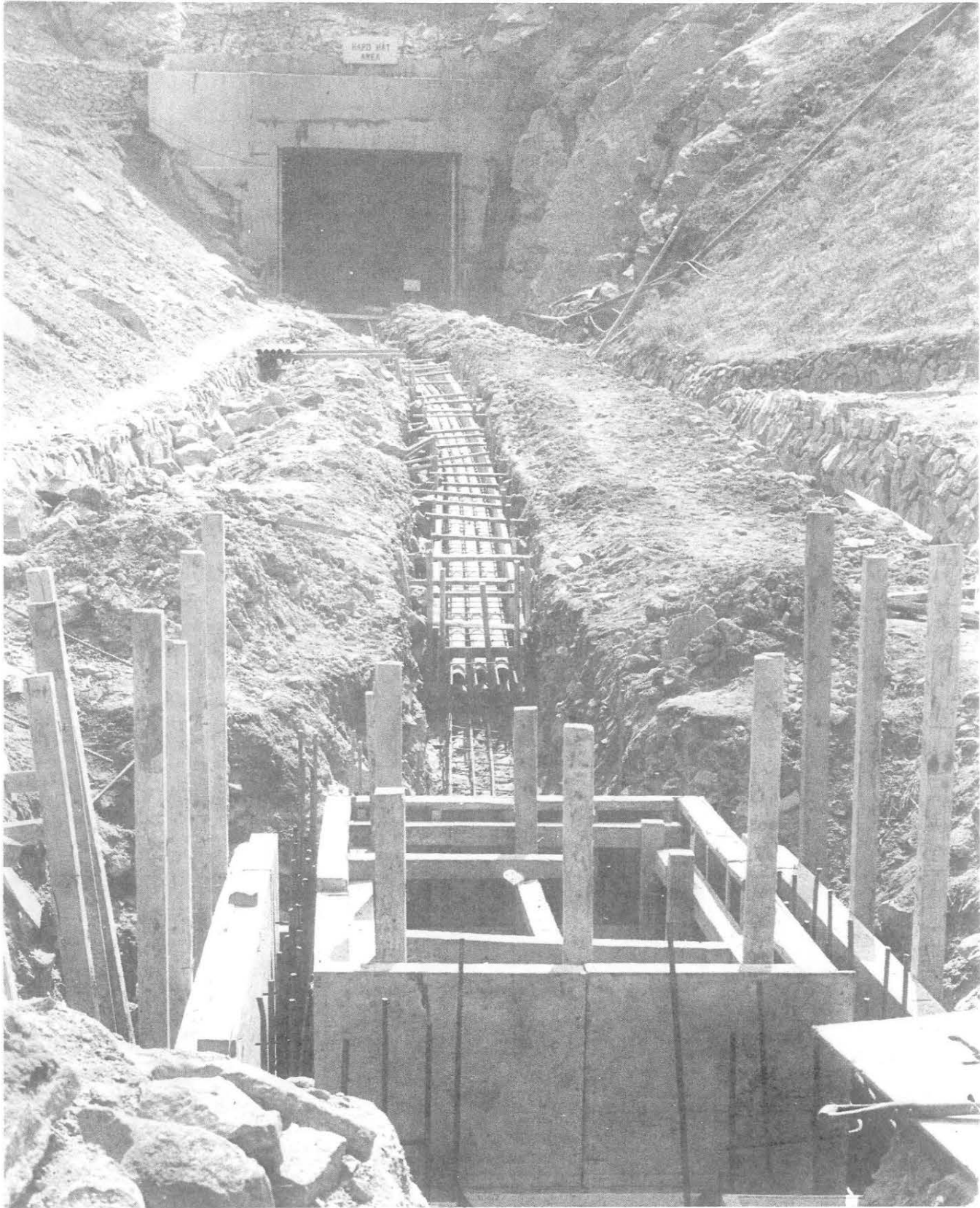
Conduit placement, Tango
