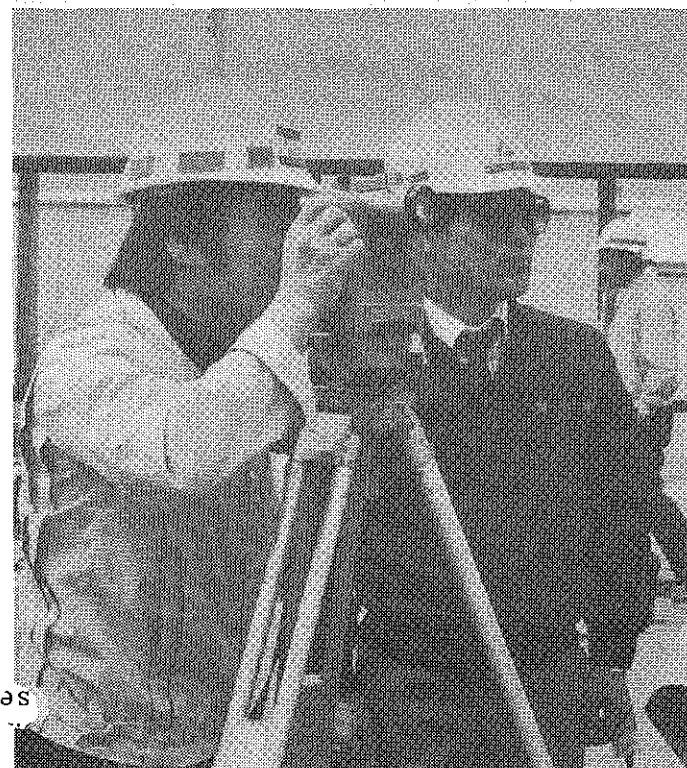
공병단 현장감독 서재수씨와 주식회사 금강 감독관 김성한 씨가 CRC 참고공사현장에서 측량기를 통하여 철골의 수직 상태를 점검하고 있다.
