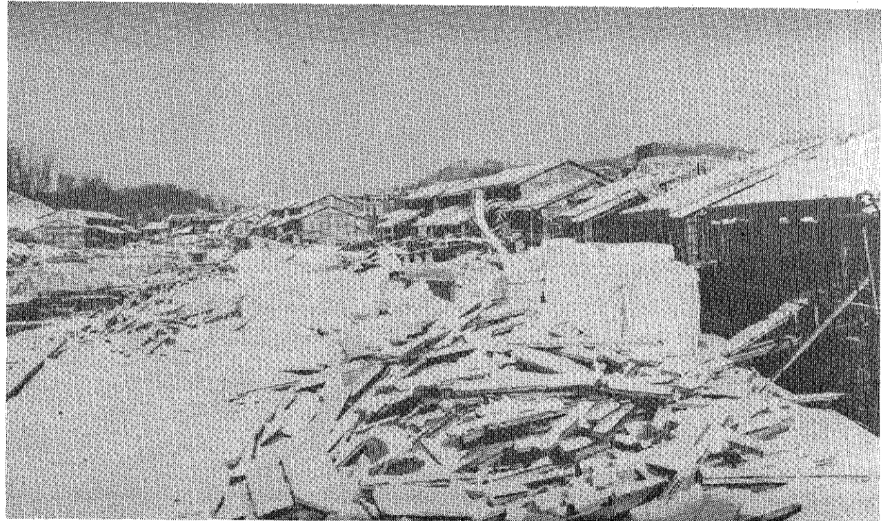
용산에 신축중인 가족주택 건설현장, 올 여름초까지 총300동의 주택이 건설된다.
